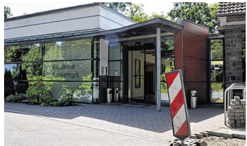
Mit einigen vorgezogenen Leitungsarbeiten für die Erneuerung der Heizungsanlage in Sankelmark wurde bereits begonnen. FOTOS: SCHNOOR (2)
